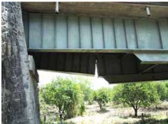
Vista lateral del puente
