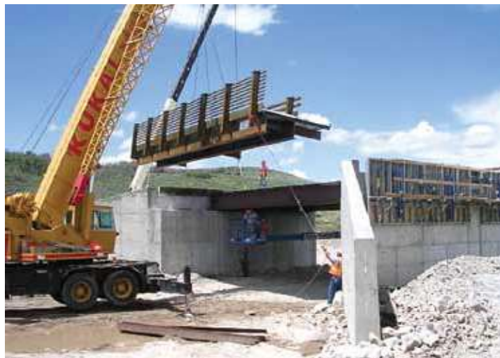
Figura 17. Colocación de puente.
