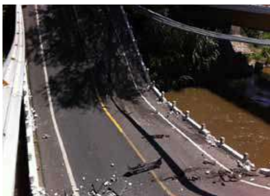
Vista general del puente
