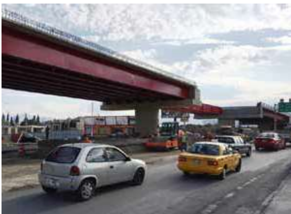
a) Vista de la construcción
