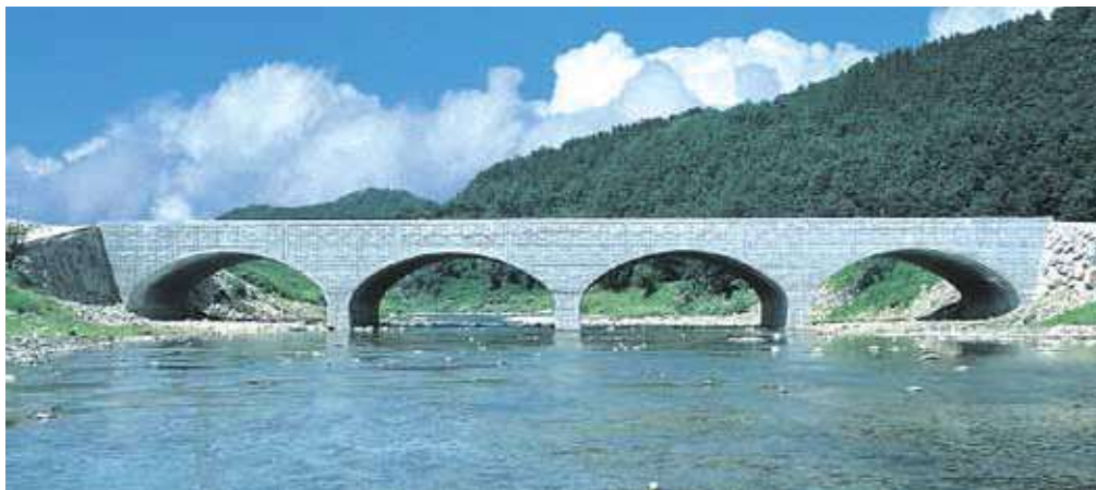
Figura 22. Puente con múltiples claros.
