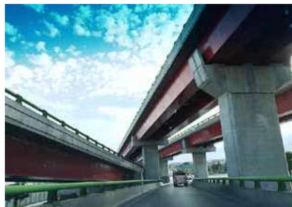
b) Vista de rampas de acceso
