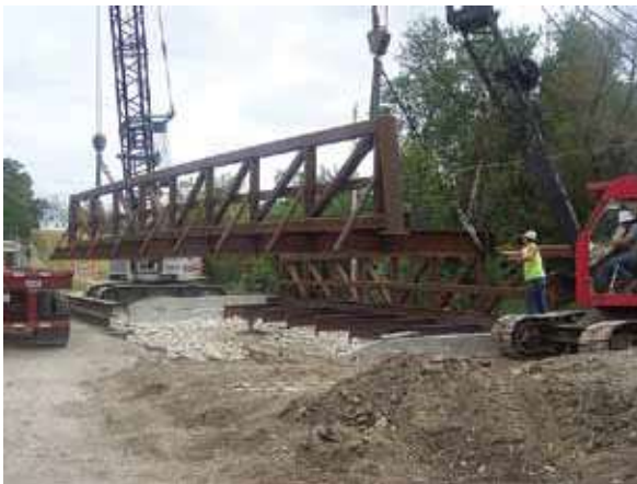
Maniobra en puente de vigas laminadas
